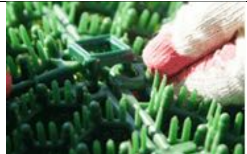
12 Les chevilles doivent être bien insérées dans les quatre trous au milieu du tapis
