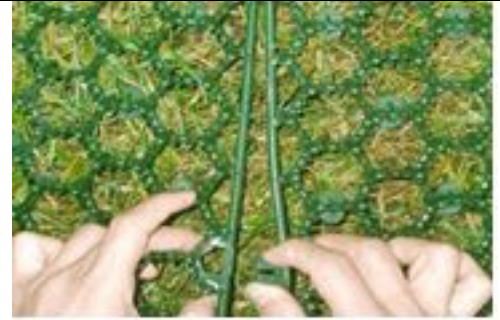
3 Remonter le tapis s'il n'est pas placé dans le sens de la marche
