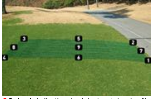
5 Ordre de la fixation des épingles et des chevilles sur les tapis
