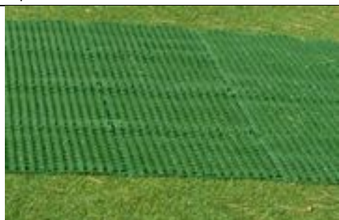
14 Notre tapis est complètement installé
