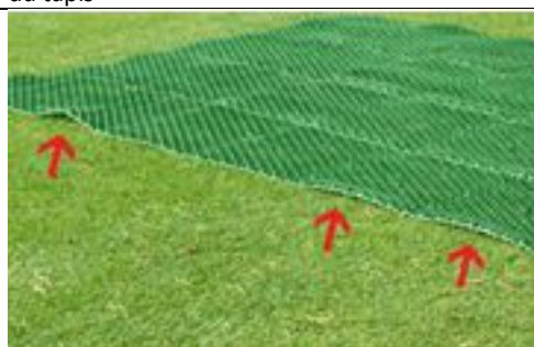
13 Des goupilles supplémentaires sont fixées si des côtés du tapis sont soulevés
