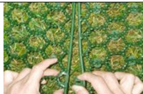
3 Remonter le tapis s'il n'est pas placé dans le sens de la marche
