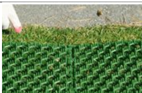
4 Distance de 5 cm à 10 cm de la route pour faciliter la fixation des épingles (pas de dégâts d'herbe)
